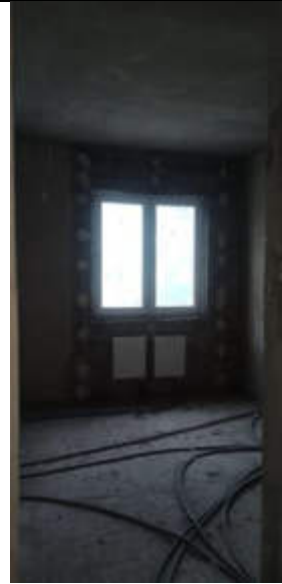
Фото N 8. Общий вид состояния помещения
