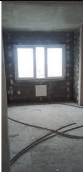
Фото N 5. Общий вид состояния помещения
