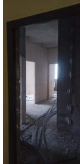
Фото N 10. Общий вид состояния помещения
