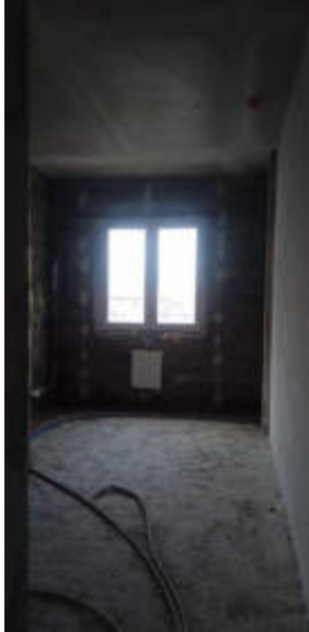
Фото N 9. Общий вид состояния помещения
