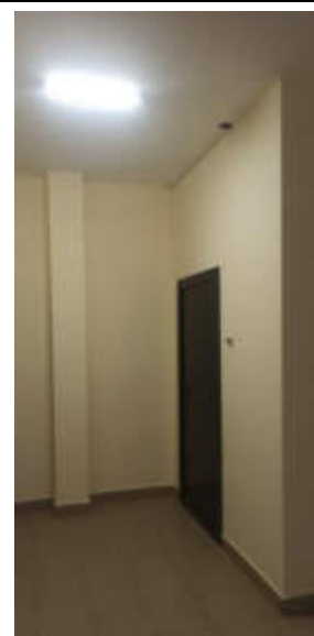
Фото N 4. Входная дверь
