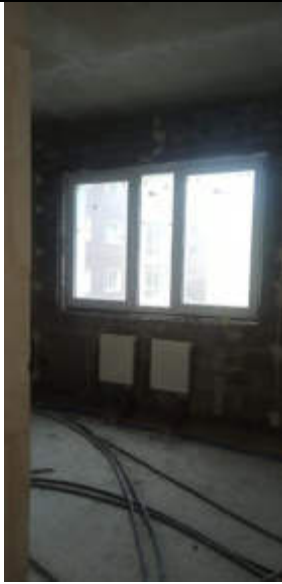
Фото N 7. Общий вид состояния помещения
