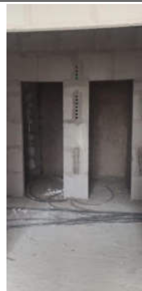
Фото N 6. Общий вид состояния помещения
